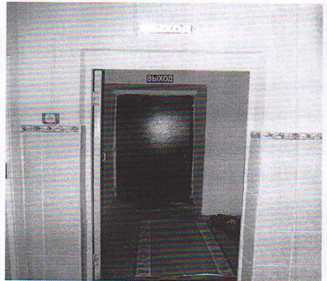
Фото № 10 Пути эвакуации
