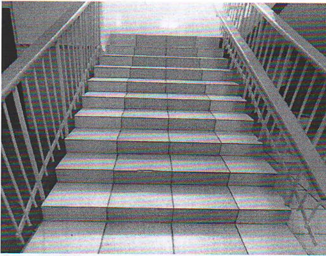
Фото № 7 Лестница внутри здания
