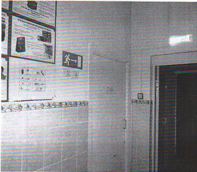
Фото № 9 Пути эвакуации
